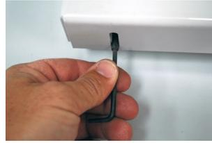
Refermer le couvercle supérieur. Visser les deux vis pointeau en les laissant dépassé d'environ 3 mm de la platine supérieur.
